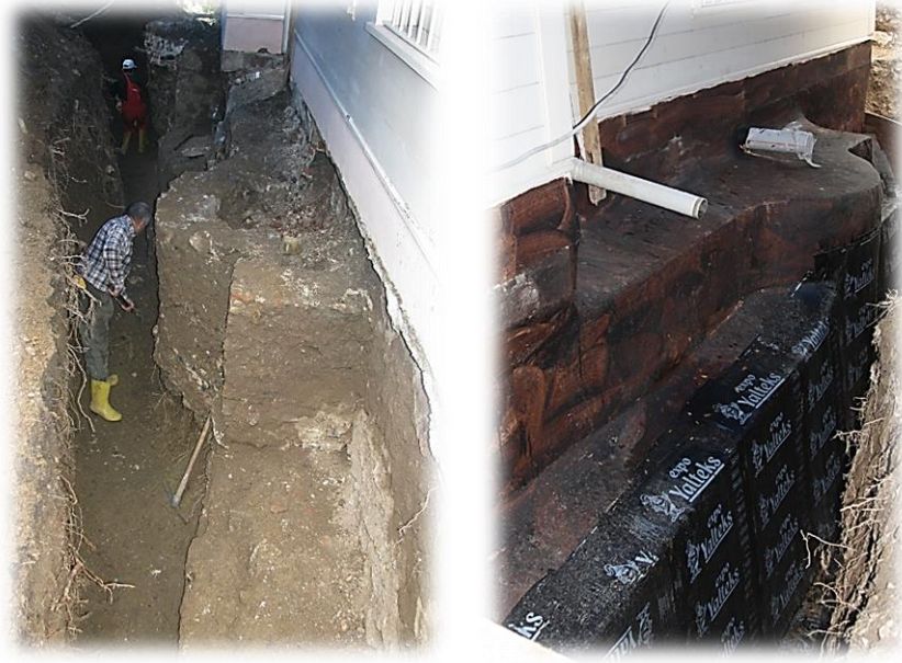
Resimler 71 – Zemin Yalıtım Çalışmaları
