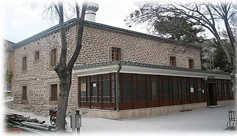
Resim 40- Konya Şems-i Tebrizi Mevlevîhânesi- Dış Görünüm-Onarım Sonrası
