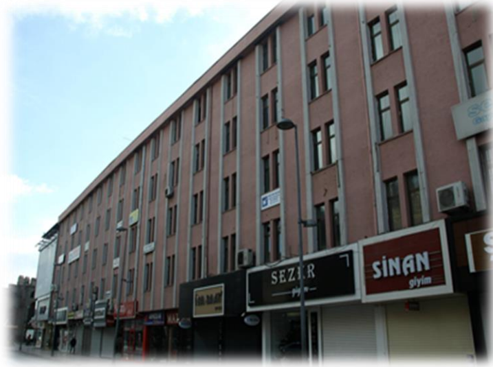
Bayram Paşa Mevlevihânesi/İşhanı Kuzey/Ön Cephesi
