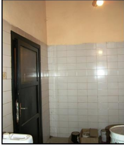
Resim 9: Depo giriş kapısı (içerden)
