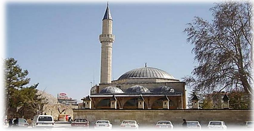
Resimler 37- Karaman Mevlevihânesi- Dış Görünüm-Onarım Öncesi-Sonrası
