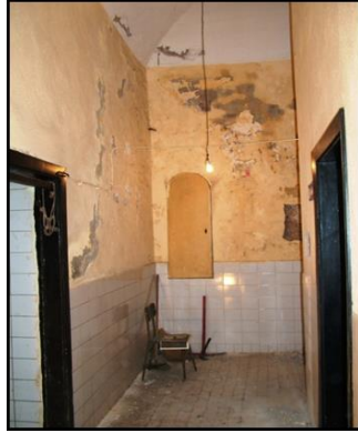
Resim 7: Ana giriş kapı karşısı (Sol mutfak, sağ depo kapısı)
