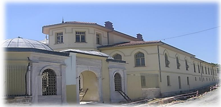
Resim 33- Yenikapı Mevlevîhânesi – Selamlık- Onarım Öncesi - Sonrası
