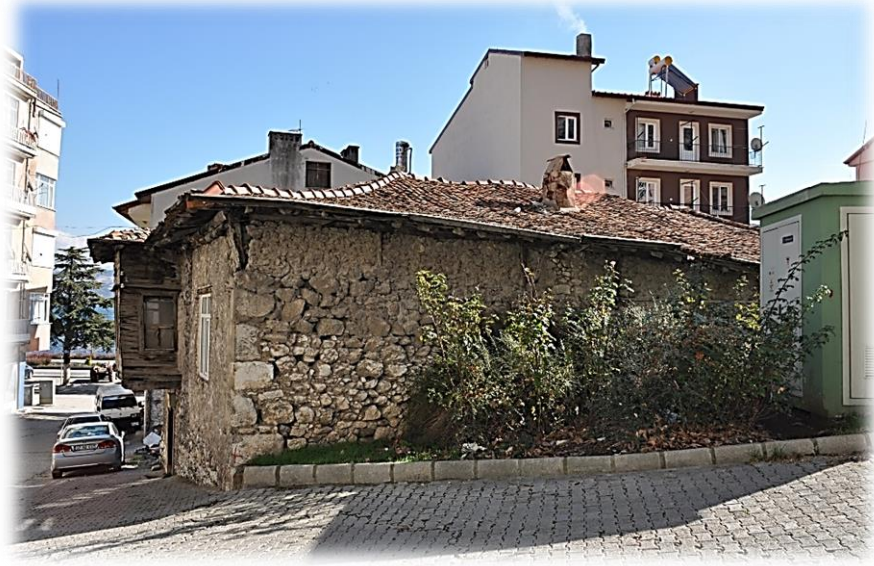
Resim 2- Eğirdir Mevlevihânesi'nin yan cephesi
