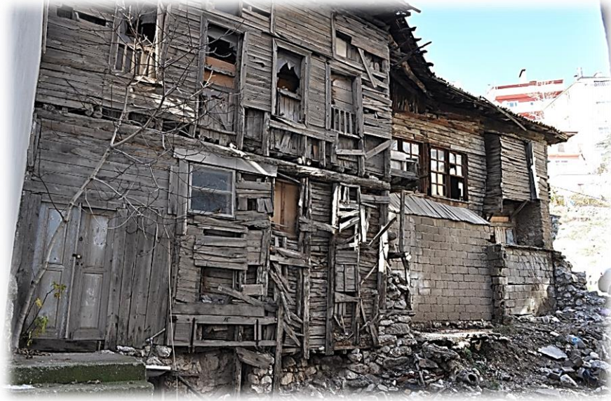
Resim 4- Eğirdir Mevlevihânesi'nin yan cephesi
