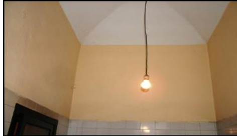
Resim 8: Depo giriş kapısı tavanı
