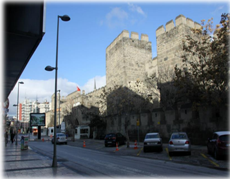
Bayram Paşa Mevlevihânesi/İşhanı Önünden Kayseri İç Kalesi Güney Surları
