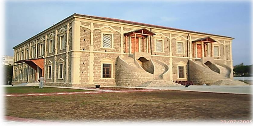
Resim 25- Gelibolu Mevlevihanesi – Dış Görünüm- Onarım Sonrası
