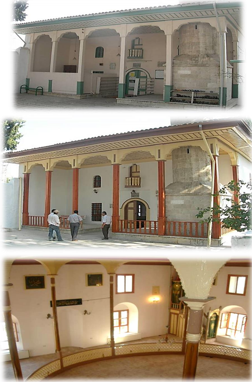
Resimler 46- Muğla Mevlevihânesi – Onarım Öncesi ve Sonrası
