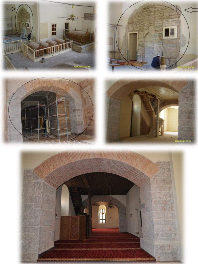
Resim: Şerbethane bölümünün tespit ve restorasyon aşamaları
