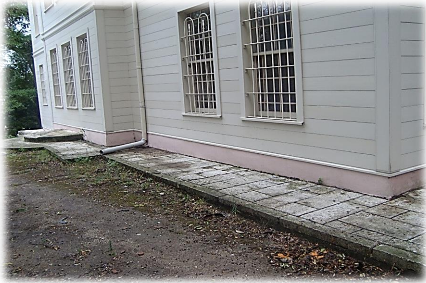
Resim 70- Cephe Yalıtım İşlemleri
