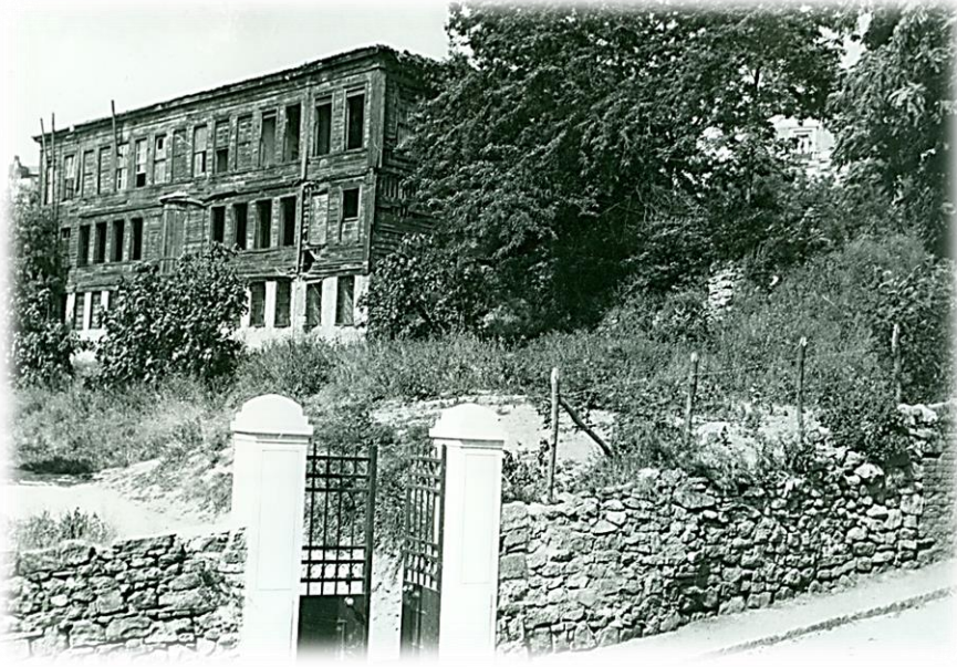
Resim 19 - Okul Müdürü Cemal Özaydın Tarafından Mevlevîhâne Etrafına Yapılan Duvar
