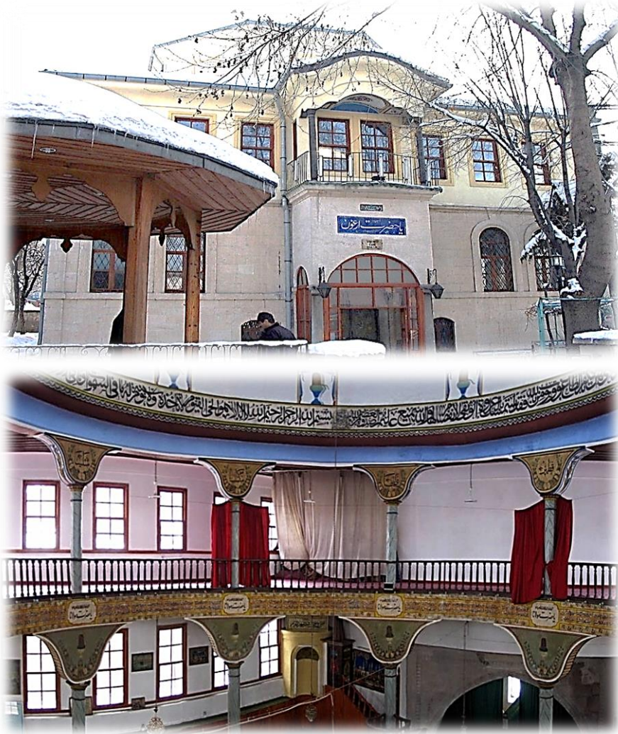
Resimler 44- Kütahya Mevlevîhânesi (Dönerler Camii) Onarım Sonrası
