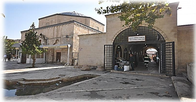
Resim 9- Urfa Mevlevîhânesi - Dış Görünüşü
