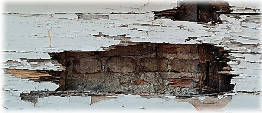
Resim 47- Mevlevihâne'nin Restorasyon Öncesi Dış Cephesi
