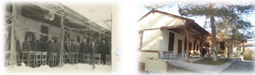
Resim: Dönemin Afyonkarahisar Vakıflar Müdürü Zeynel BALKAN 2 tarafından yapılan çalışma neticesi aşevine dönüştürülen Derviş Odaları açılış töreni - 2 Şubat 1956- (solda) 3 , 2007 restorasyonu hemen öncesi (sağda).
