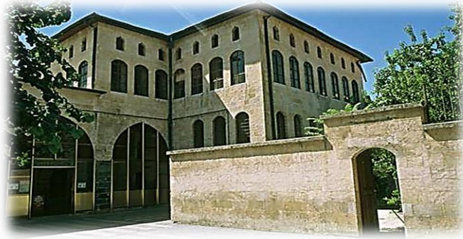
Resim 19- Antep Mevlevîhanesi – Tekke Binası
