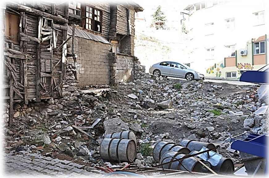
Resim 5- Eğirdir Mevlevihânesi'nin yan cephesi
