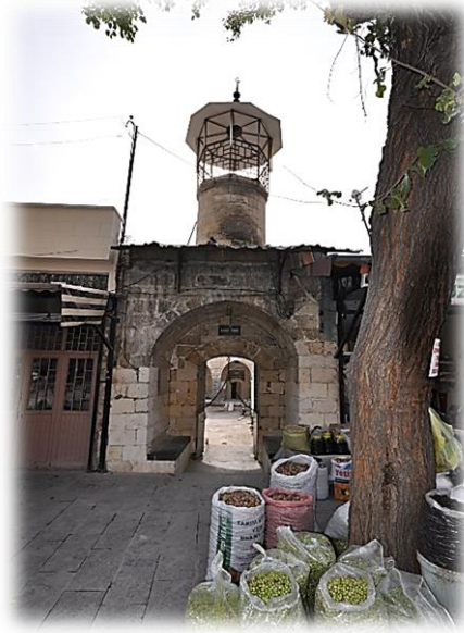
Resim 4- Antep Mevlevihânesi - Dış Kapısı
