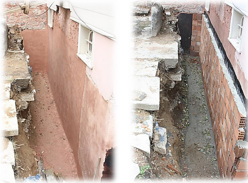
Resimler 72- Zemin Yalıtım Çalışmaları
