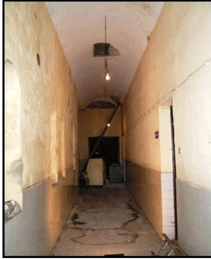
Resim 11: Koridordan lavabo kapısına bakış (solda nişler, sağda ambar kapısı)
