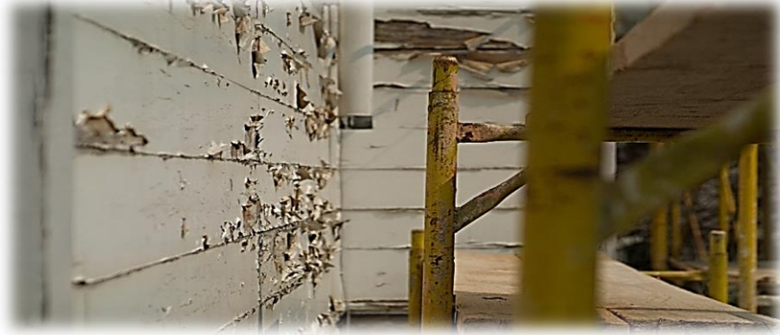
Resim 46- Mevlevihâne'nin Restorasyon Öncesi Dış Cephesi
